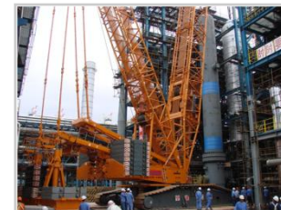
Fujian 2009 Asphalt 3x1200 t/d
